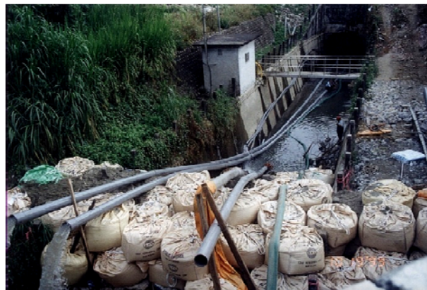
石岡壩受損進水口無法取水 南幹渠隧道口擋抽排水以利進入檢查 隧道段180公尺處斷裂漏水
