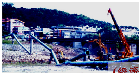
一江橋水管橋
