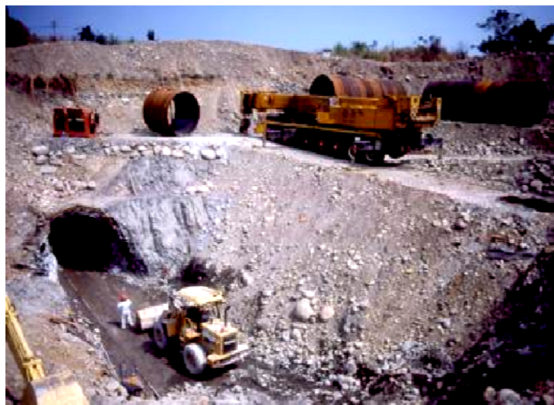
石岡壩受損進水口無法取水 南幹渠隧道口擋抽排水以利進入檢查 隧道段180公尺處斷裂漏水
