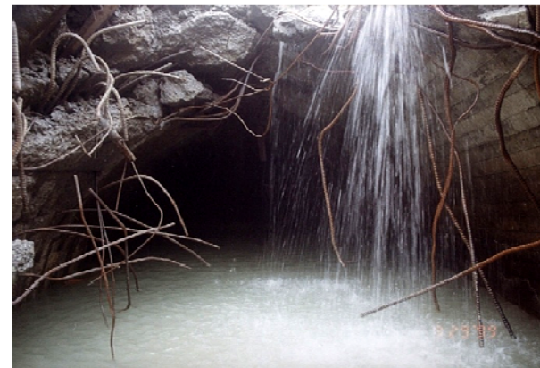
石岡壩受損進水口無法取水 南幹渠隧道口擋抽排水以利進入檢查 隧道段180公尺處斷裂漏水
