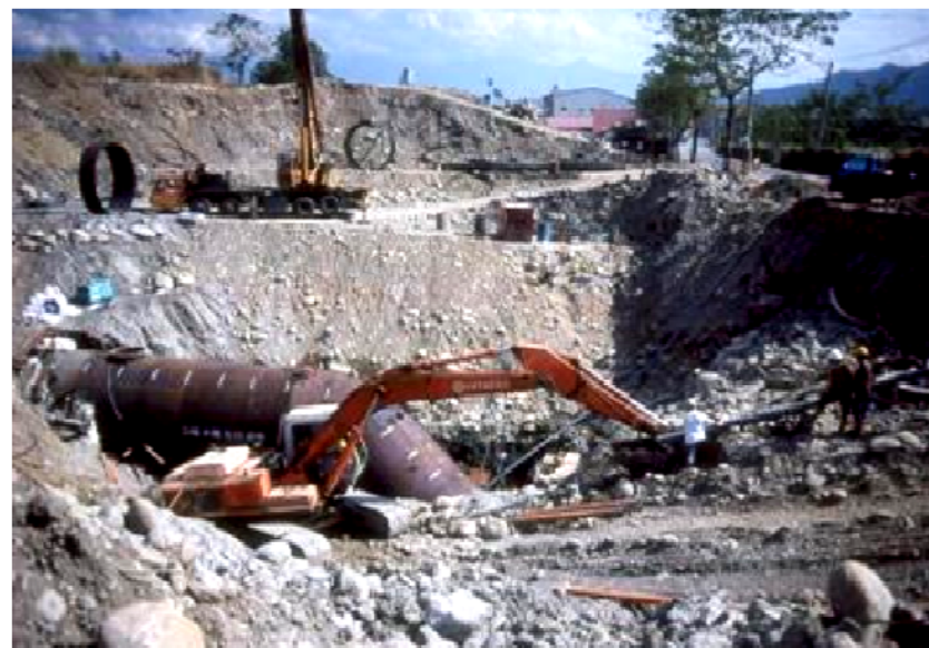
石岡壩受損進水口無法取水 南幹渠隧道口擋抽排水以利進入檢查 隧道段180公尺處斷裂漏水
