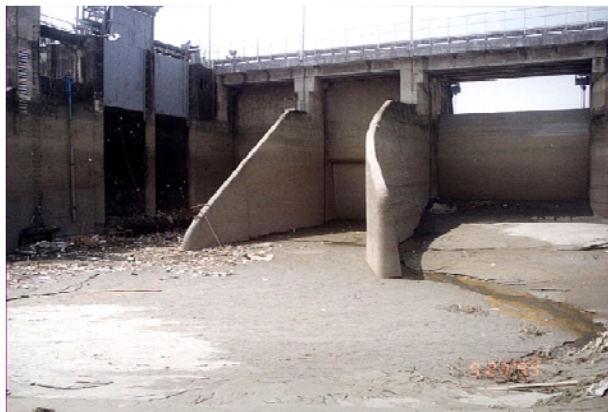
石岡壩受損進水口無法取水 南幹渠隧道口擋抽排水以利進入檢查 隧道段180公尺處斷裂漏水
